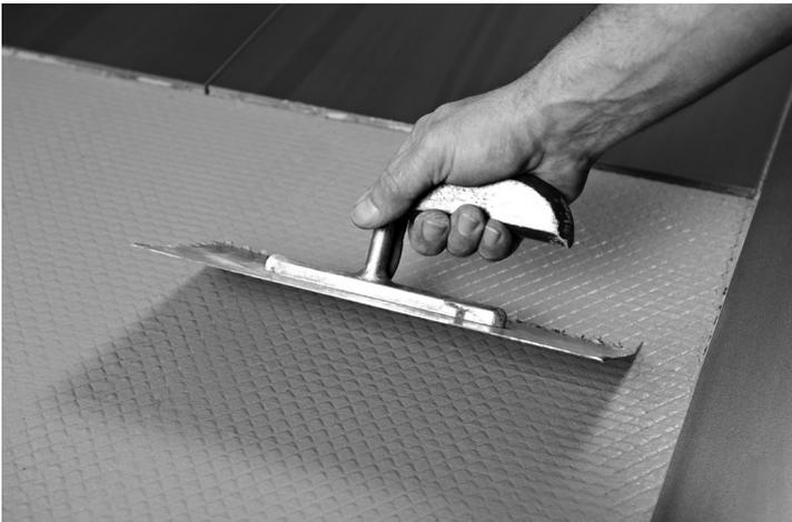
6. Die Vertiefungen der Gitterstruktur werden mit Fliesenkleber gleichmäßig und vollständig gefüllt. Mit der auf das Mosaik / die Fliese abgestimmten Zahnpachtel (4 oder 6 mm Zahnung) wird dann der Fliesenkleber frisch in frisch aufgekämmt und die Fliesen eingelegt.
