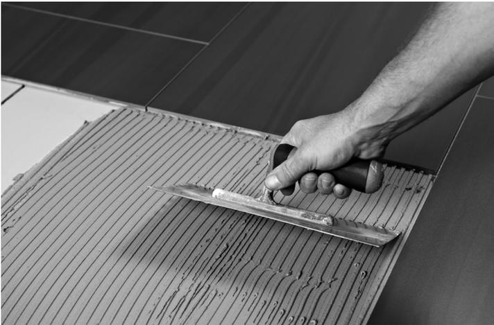
3. Fliesenkleber nach DIN 12004 C2 bzw. 12002 S1 auf den Untergrund auftragen. Zu aufsteigenden Bauteilen sind Einspannungen zu verhindern!
