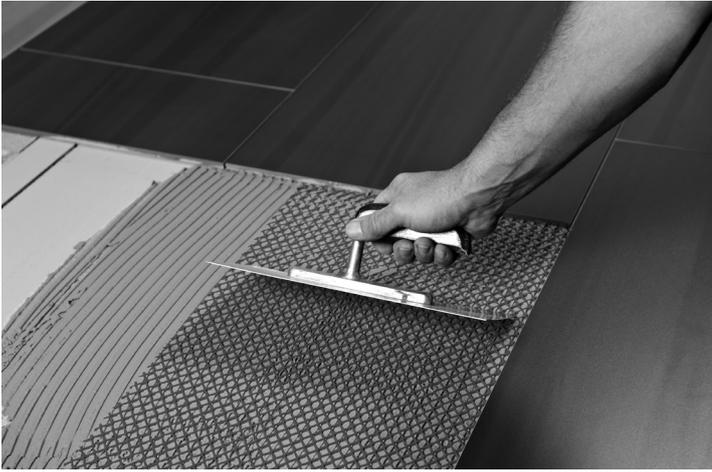
5. Die Höhenausgleichsmatte vollflächig in den kleboffenen Verlegemörtel bis zur Bodenberührung eindrücken und mit Hilfe eines Reibbretts bzw. einer Andruckwalze andrücken.
